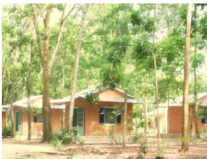
Hình 63. Khu thất trong tu viện
