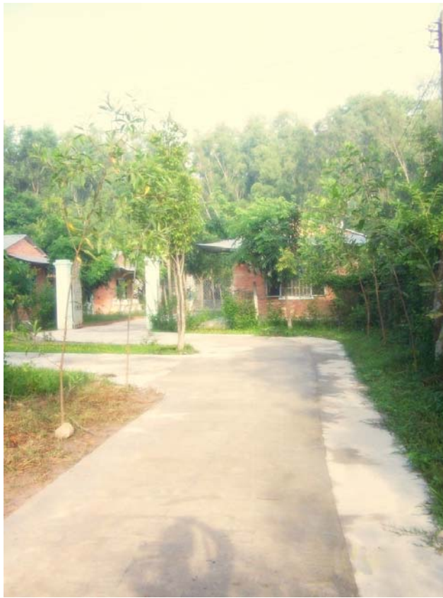
Hình 70. Đường vào khu phát triển
